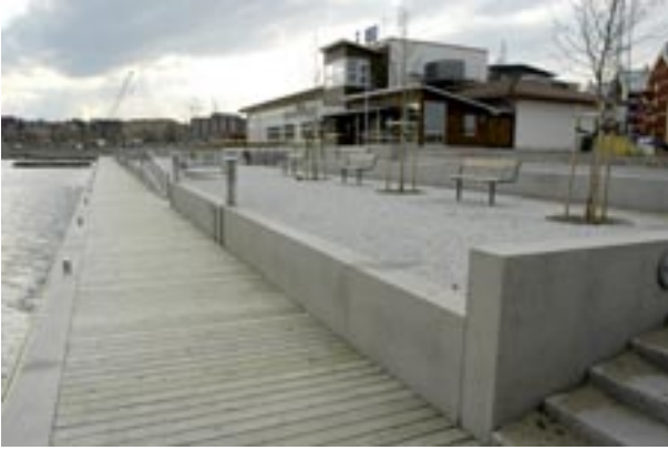
Fig 9.2 Kajläggning uppbyggd av granitblock med flammad yta.
