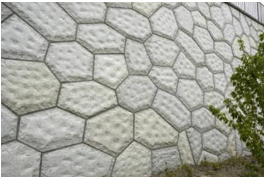
Fig 2.3 Leverans av polygonmur, tv, och blockmur, th, från fjärran land. Utseendet är inte vad beställaren hade förväntat sig, trots att stenen uppfyller alla krav enligt beskrivningen. Stenarna i polygonmönstret har en alltför jämn och enhetlig storlek. Ytbearbetningen ger i båda exemplen ett onaturligt intryck.
