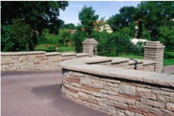
Fig 10.6 Grindstolpar och mur av kallmurad kalksten.
