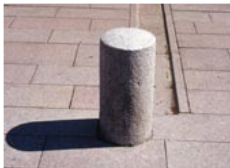
Fig 10.3 Cylindrisk, krysshamrad granitpollare. Rännstensplattor av flammad granit.
