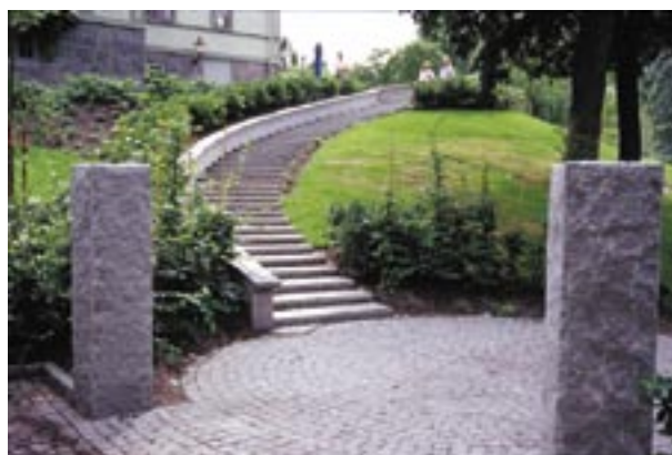
Fig 10.4 Grindstolpar av råkilad granit.
