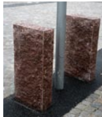
Fig 10.9 Påkörningsskydd av råkilad granit.
