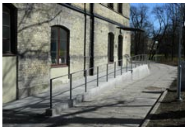
Fig 1.10 Ram uppbyggd av granithällar och blockstensmur ger tillgänglighet till äldre byggnad.
