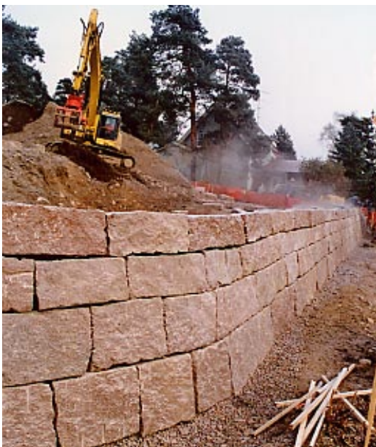
Fig 1.2 Kallmur av staplade råblock
